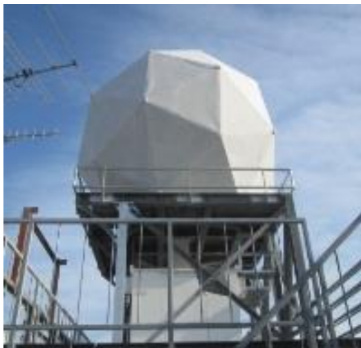
MPレーダー（降雨と風速の三次元構造）
